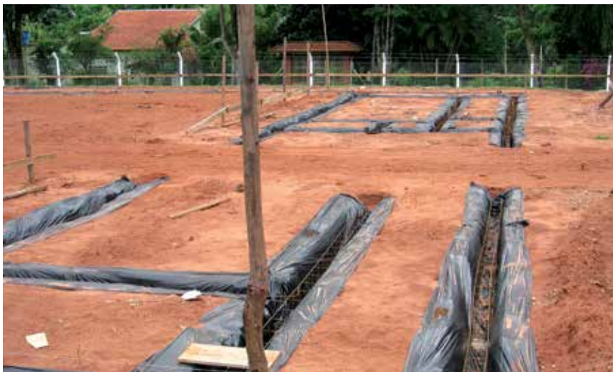
Construção da quadra coberta na Subsede de Bauru, prevista para ser concluída em janeiro
