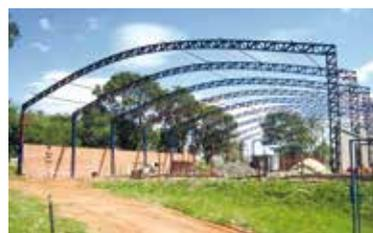
A construção do ginásio na Subsede de Bauru está a todo vapor! Na última semana foram instalados os arcos necessários para o processo de soldagem e sustentação do telhado. No total, serão utilizados 12 arcos que medem 26 metros de extensão e pesam 1 tonelada.
